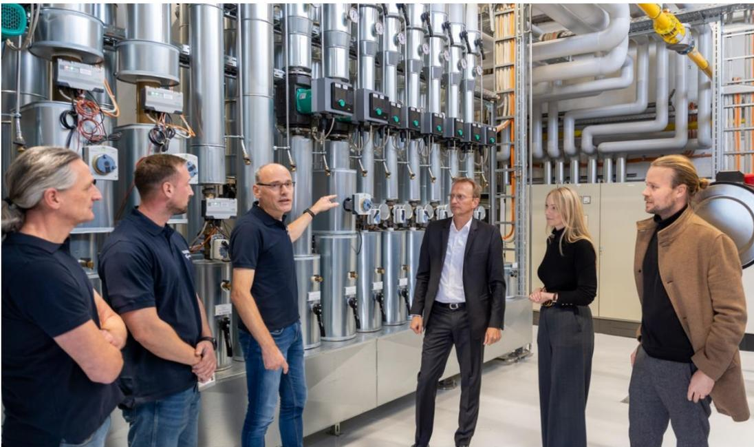
In einem einzigartigen Verfahren nutzt Flender die Abwärme seiner Härtereier zum Heizen des Standorts in Bocholt. Dadurch werden fast 2,4 Millionen Kilowattstunden Erdgas eingespart und 400 Tonnen weniger CO<sub>2</sub> emittiert.
